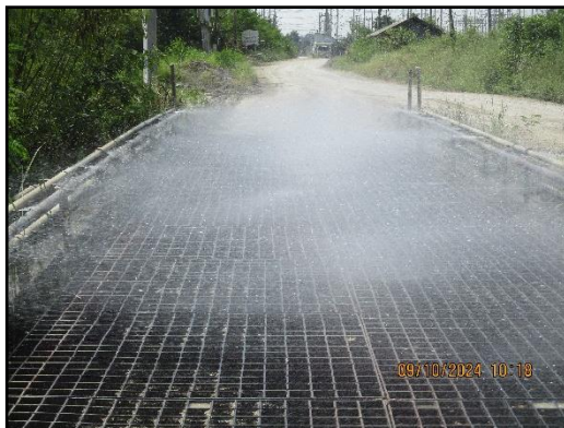
ภาพที่ 2.10 บ่อล้างล้อรถบรรทุก ในช่วงถนนคอนกรีตของเส้นทางขนส่งแร่
