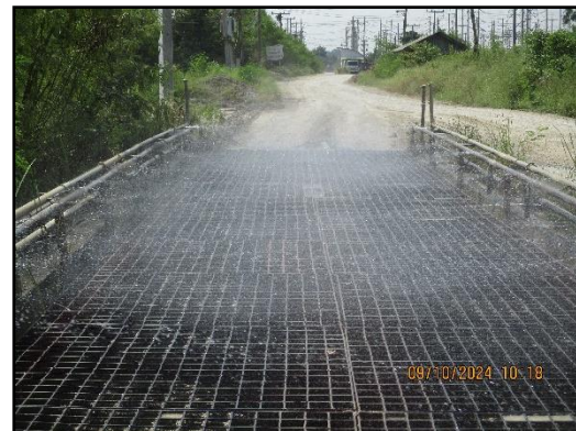
ภาพที่ 2.10 บ่อล้างล้อรถบรรทุก ในช่วงถนนคอนกรีตของเส้นทางขนส่งแร่
